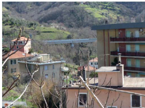
Viadotto A7 direzione Milano (accanto è previsto il passaggio della Gronda)
