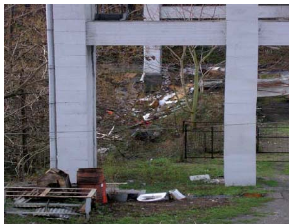
Presenza di materiali di varia origine sotto i piloni dell'A7
