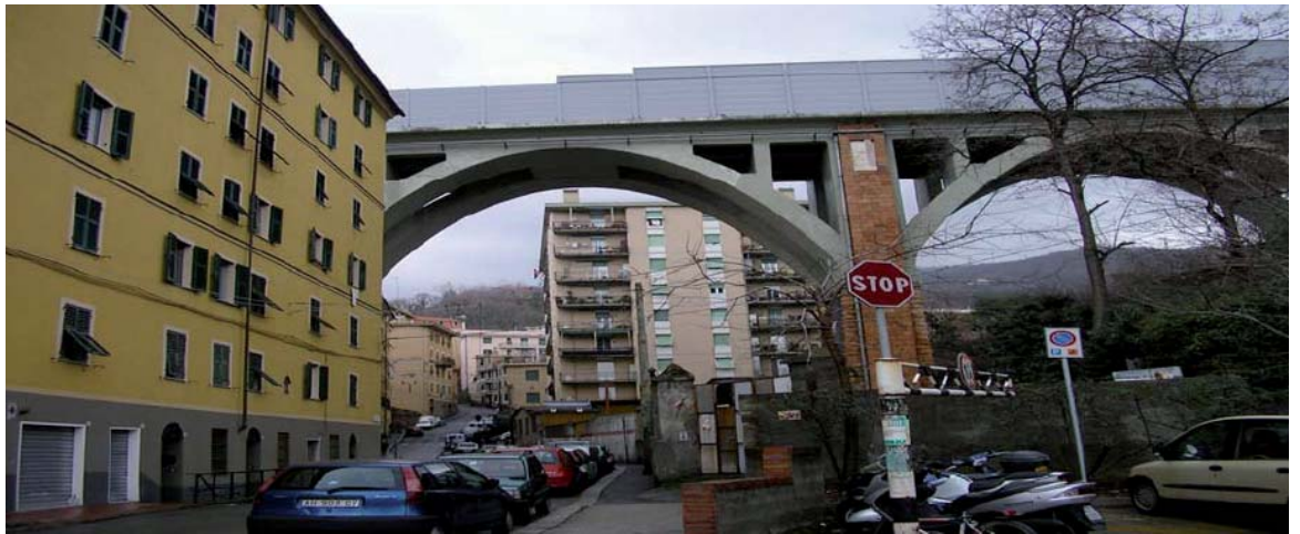
Viadotto A7 direzione Genova
