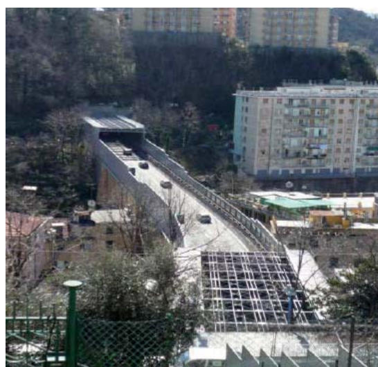
Viadotto A7 direzione Genova
